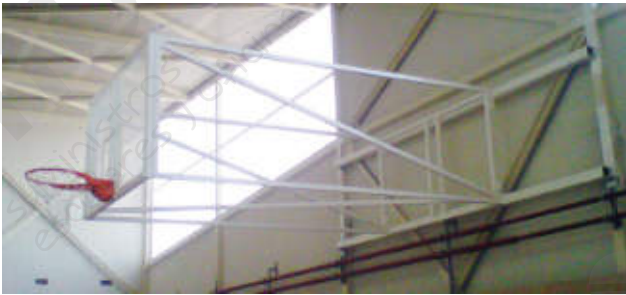
Canasta de 2,5 m entre cerchas mediante estructura metálica soldada y cable tirante de sujeción.
