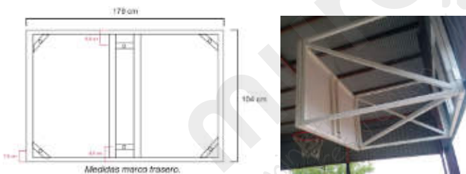
Canasta de 2,5 m entre cerchas mediante estructura metálica soldada y cable tirante de sujeción.
